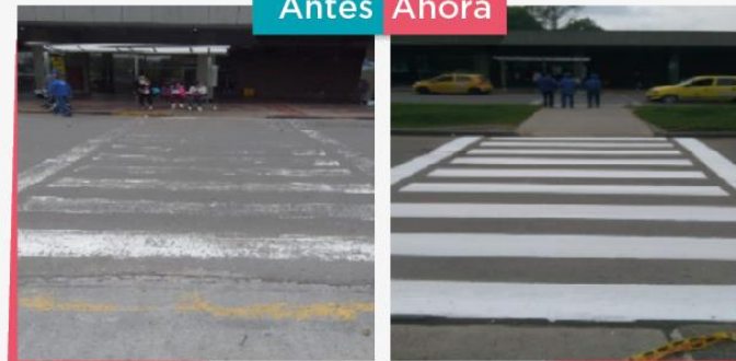
MANTENIMIENTO MENOR DE LA INFRAESTRUCTURA
