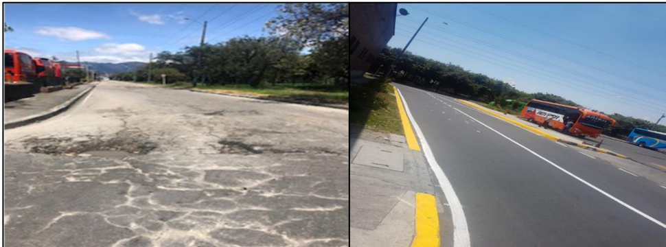
Figura 21. Mantenimiento de vías – oreja lavaderos Salitre
