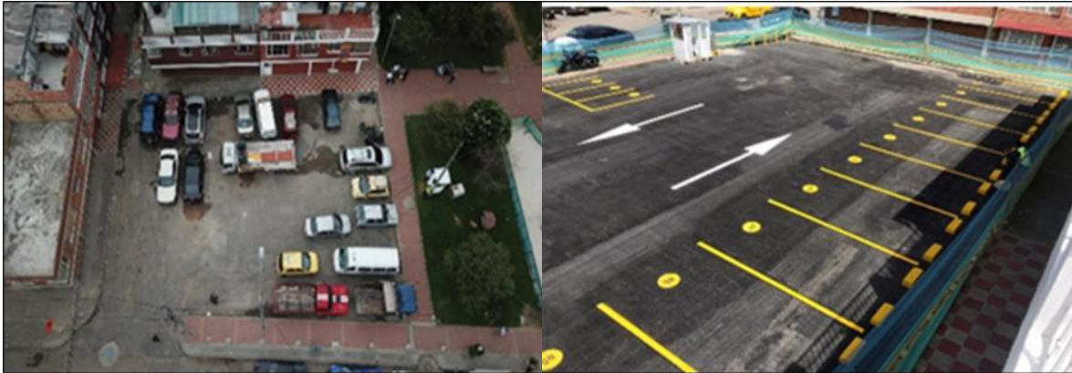
Figura 33. Intervención infraestructura parqueadero Gloria Lara - Suba
