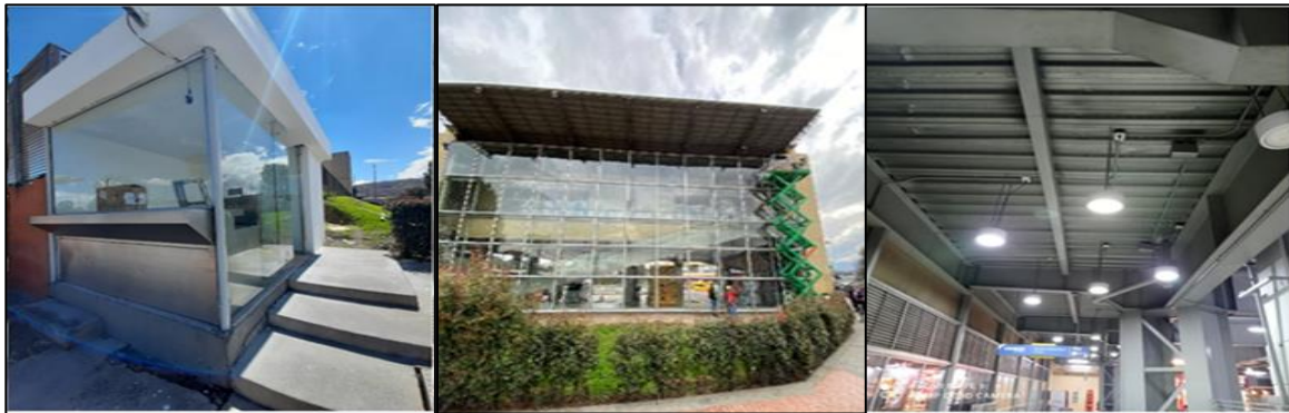
Figura 24. Mantenimientos menores en las tres sedes de La Terminal
