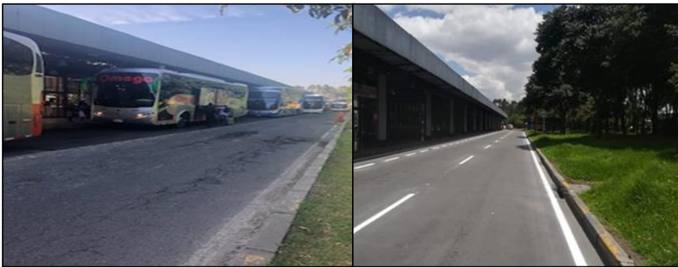
Figura 22. Mantenimiento de vías – zona descensos Salitre
