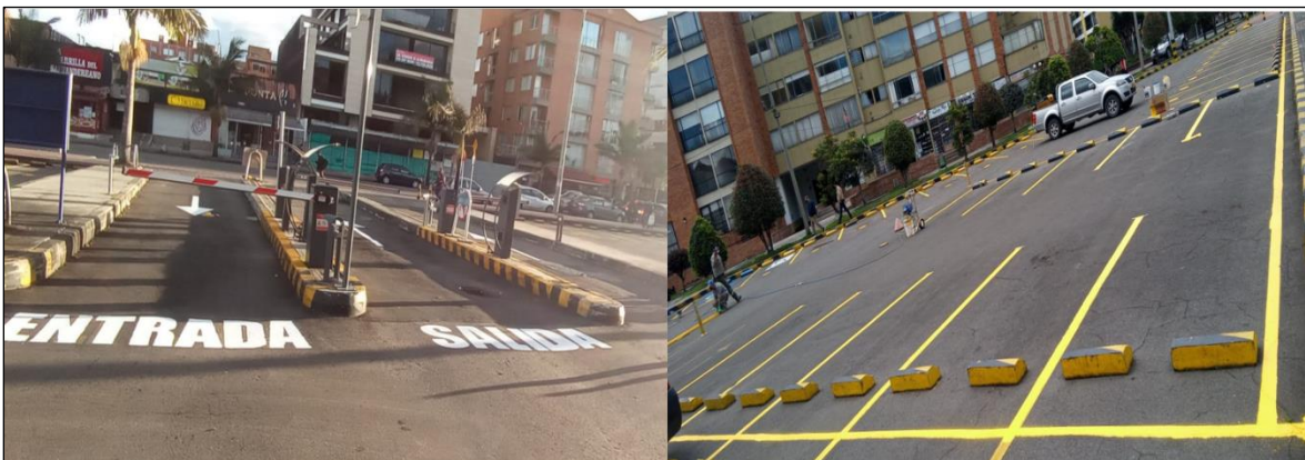
Figura 34. Intervención infraestructura parqueadero Calle 125
