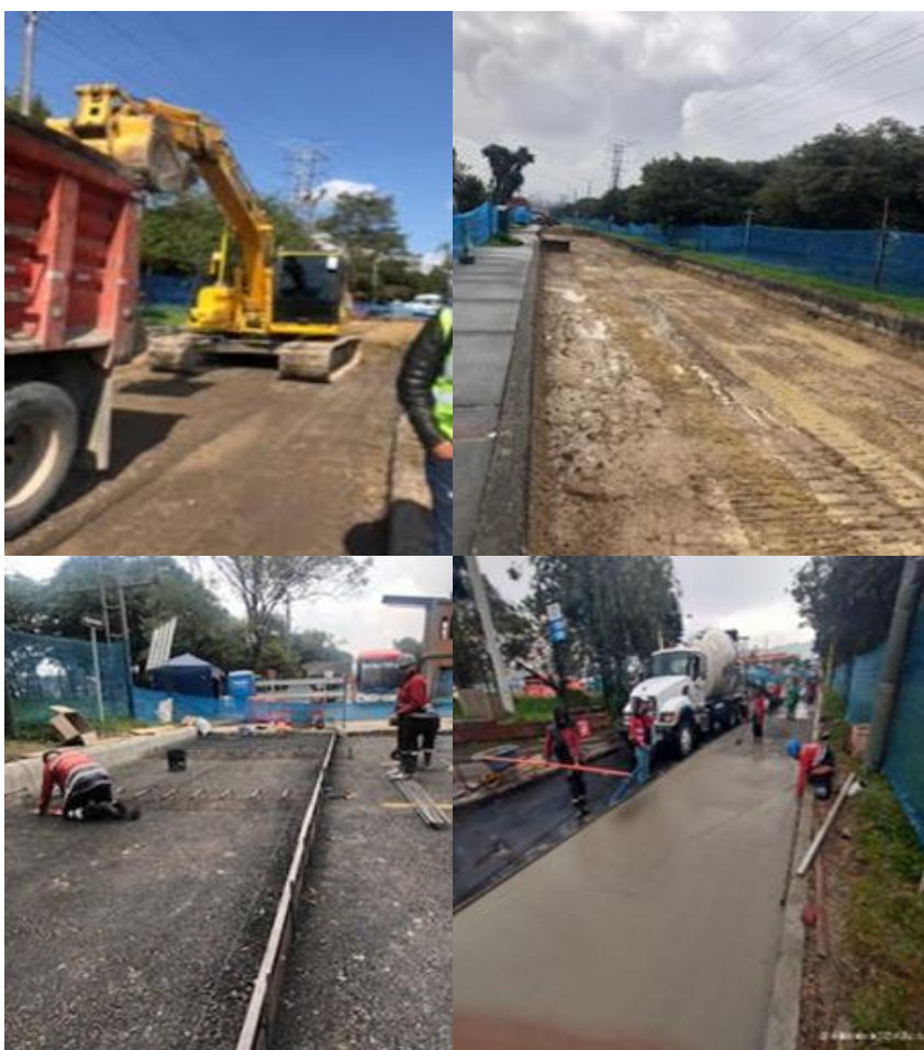
Ilustración 25. Obras de recuperación de 1600m 2 de malla vial en la Terminal Salitre
