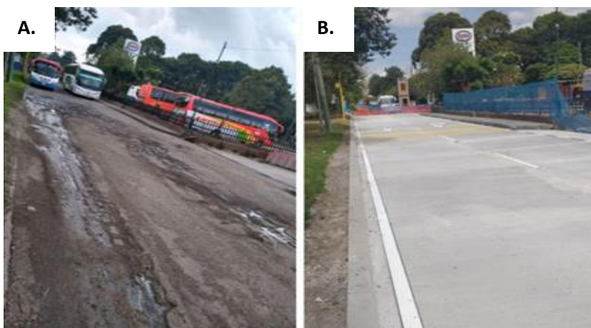
Ilustración 24. A. Antes de obras de recuperación de 1600m 2 de malla vial en la Terminal Salitre B. Tramo de recuperación de 1600m 2 de malla vial en la Terminal Salitre
