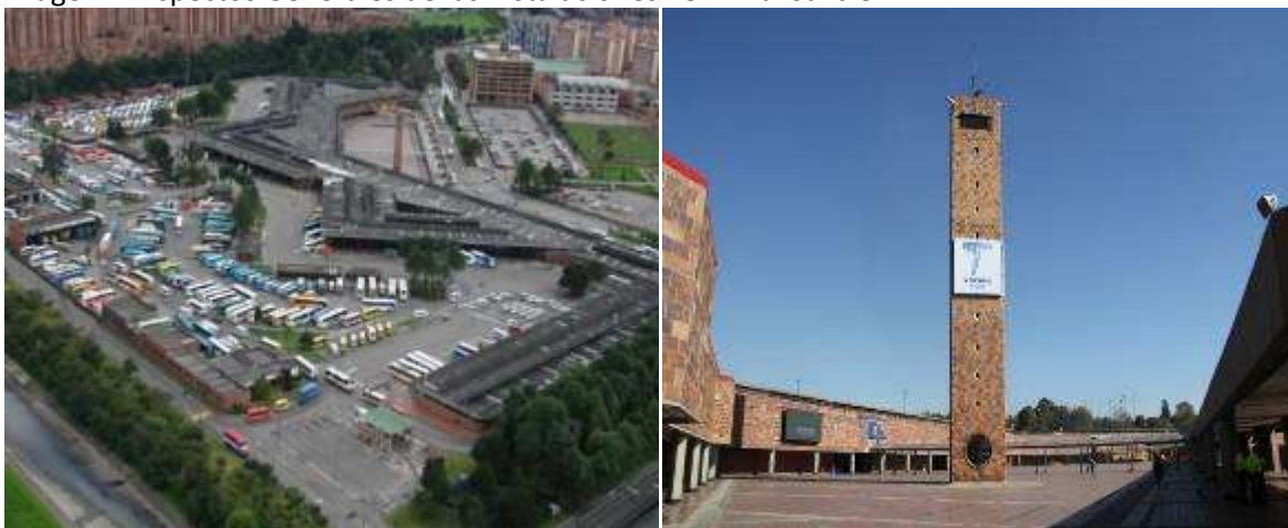
Imagen 1. Aspectos Generales de las Instalaciones Terminal Salitre
