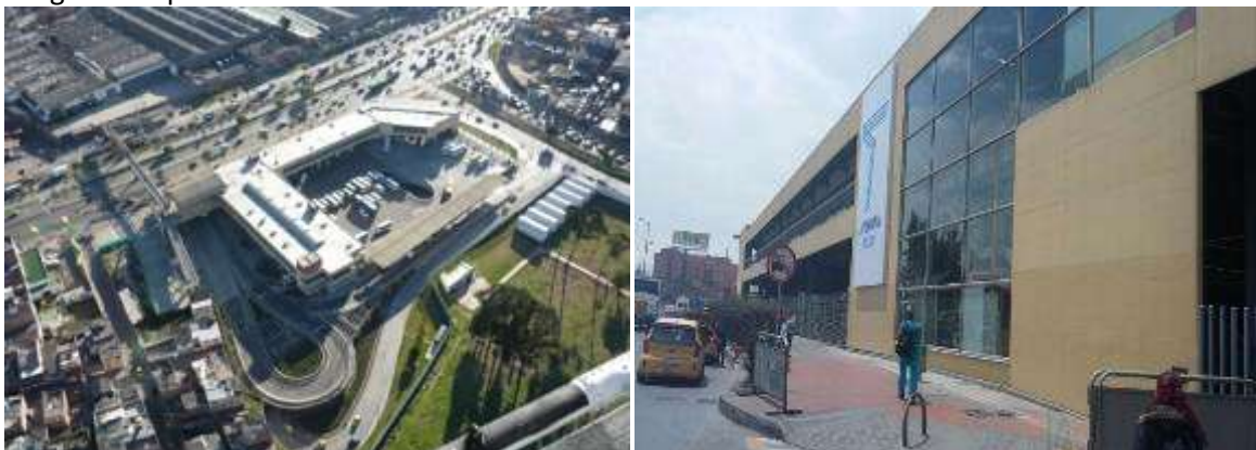
Imagen 2. Aspectos Generales de las Instalaciones Terminal del Sur
