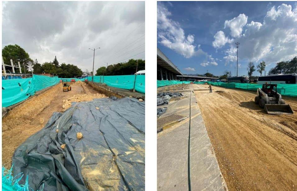
Ilustración 38. Obras fase II. Recuperación malla vial
