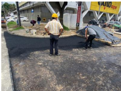
Reparación del pavimento en Modelia 1. Mayo de 2022
