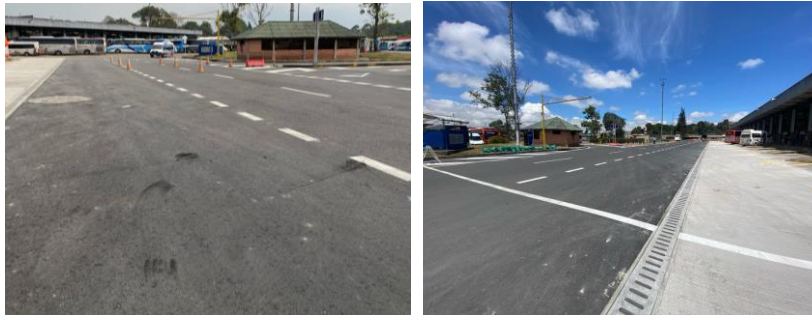
Ilustración 10. Mantenimiento y recuperación de la carpeta asfáltica.
