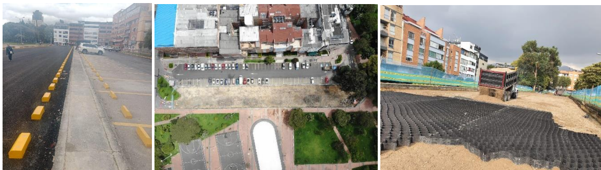
Ilustración 28. Mejoramiento de la infraestructura de estacionamientos fuera de vía en Nicolás de Federmán
