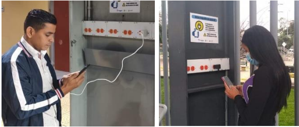
Ilustración 20. Puntos de recarga para celular Terminales Satélites Norte y Sur
