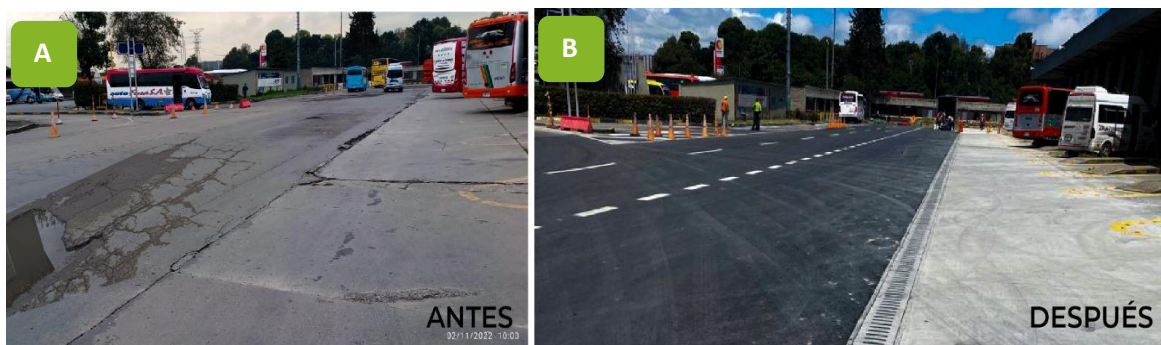
Ilustración 15. A. Estado de la malla vial antes de la intervención. B. Recuperación de la malla vial Módulos I y II
